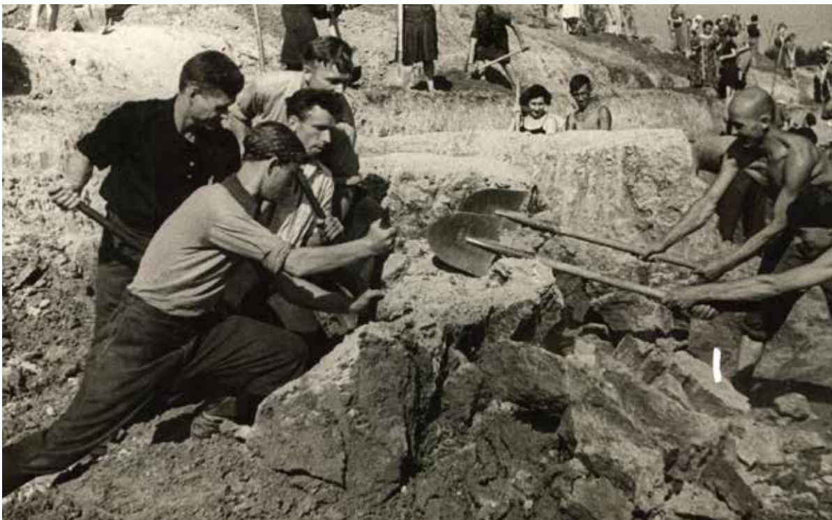
Иллюстрация 11. Ленинградцы на строительстве оборонительных рубежей. ГМПир КП 32431/13. Ф. III-36300/1. ГК № 3249112.
