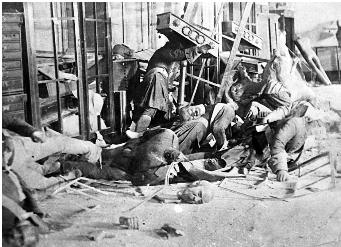
Иллюстрация 32. Залы верхнего этажа музея с разрушенным музейным оборудованием и экспонатами после взрыва бомбы 11 сентября 1941 года. ВИМАИВиВС. Фонд фотодокументов. Инвентарный № 7/5007.
